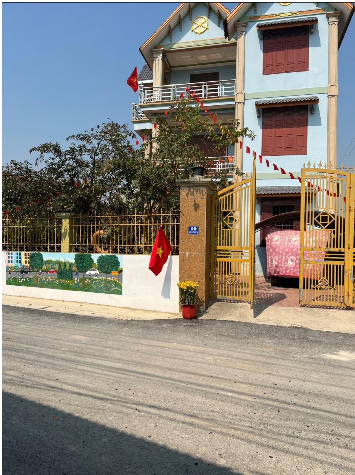
3. xây lắp nắp đậy cho rãnh thoát nước trong khu dân cư:
